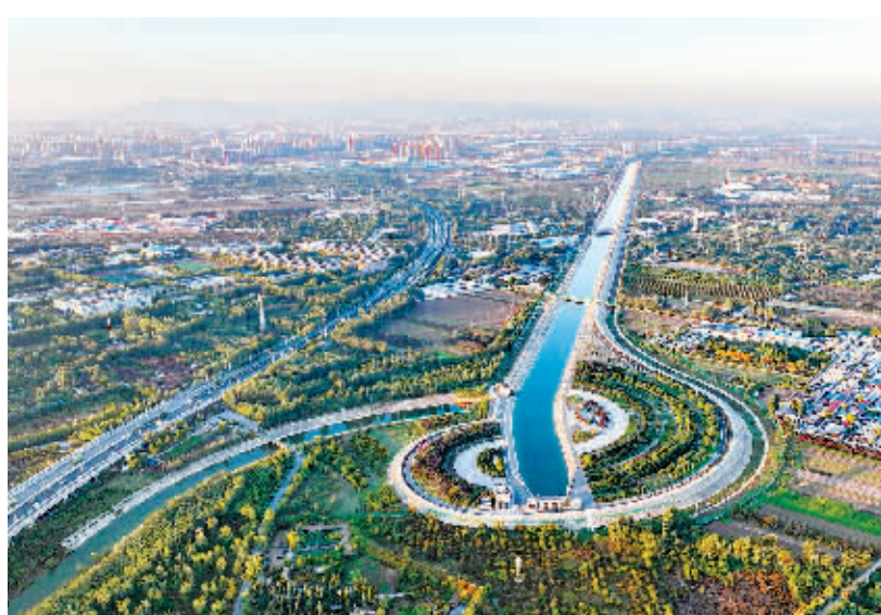
图为南水北调中线滹沱河倒虹吸和退水闸工程。 本报记者 梁子栋 摄
