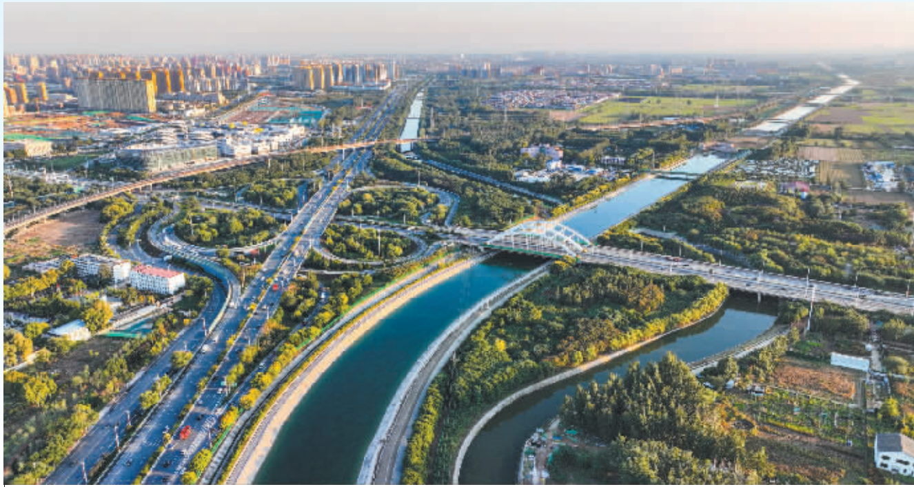
图为南水北调中线工程石家庄段。
