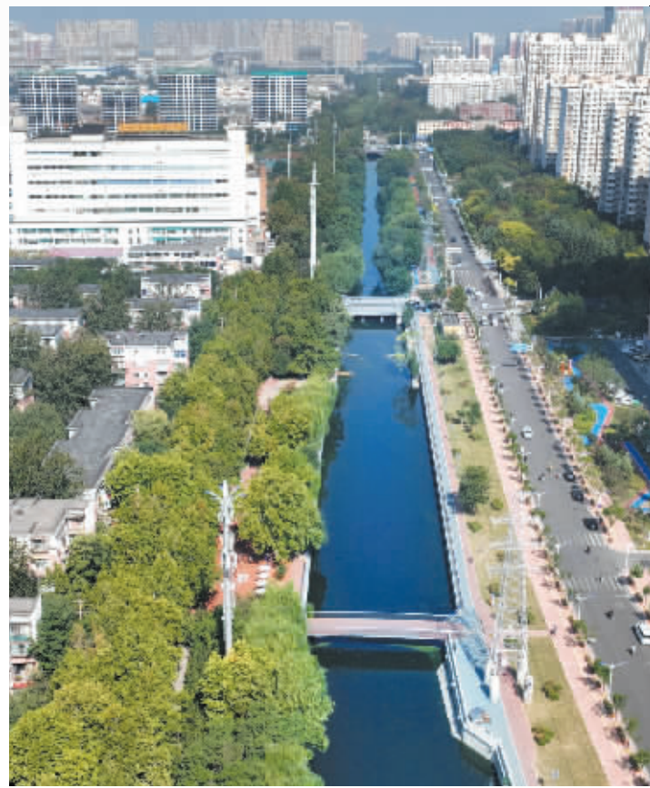
石家庄市的民心河部分河段用的是再生水。
