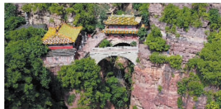
图为石家庄市井陘县苍岩山福庆寺桥楼殿。本报记者 张峻峰 摄
