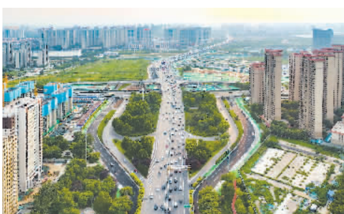
图为7月31日,石家庄南二环(胜利南大街—仓兴街)辅路连通工程通车。本报记者 张晓峰 摄
