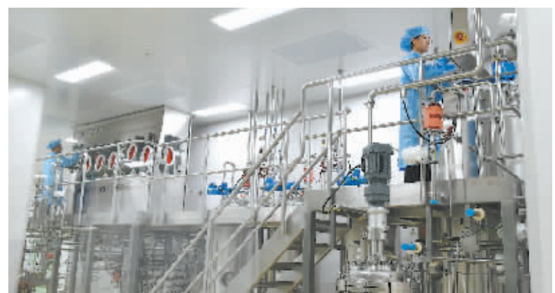
图为在绿叶嘉奥石家庄生产基地,工作人员正在进行设备调试。 本报首席记者 张 震 摄
