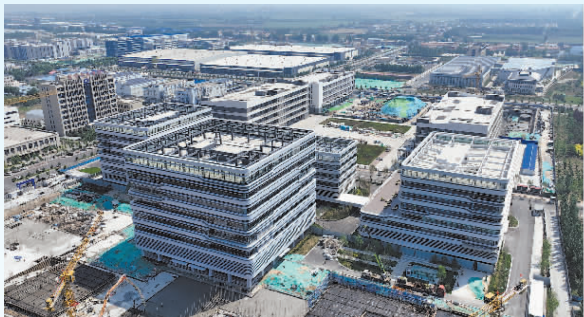
石家庄经济技术开发区京津冀协同创新承载中心项目一期基本完工,已与北京、天津、河北等地的10余家企业签订了入驻协议。本报首席记者 张震 摄
