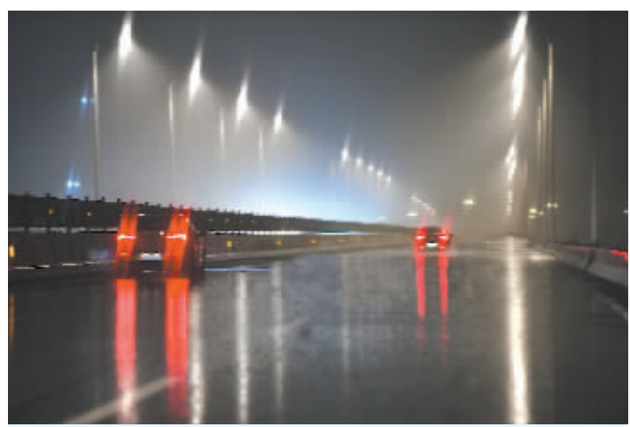
图为7月15日22点,石家庄东二环改造工程主桥实现通车。本报记者 张晓峰 摄
