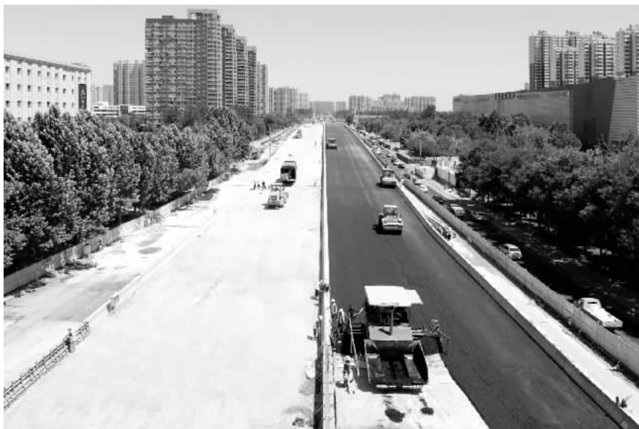
6月25日，在我市东二环提升改造施工现场，工作人员正在铺设沥青路面。东二环(南二环—裕华路)提升改造项目正在有序进行，该工程将有效打通沿线槐北路、塔南路等6条东西向道路，方便市民出行。 本报记者 董永博 摄
