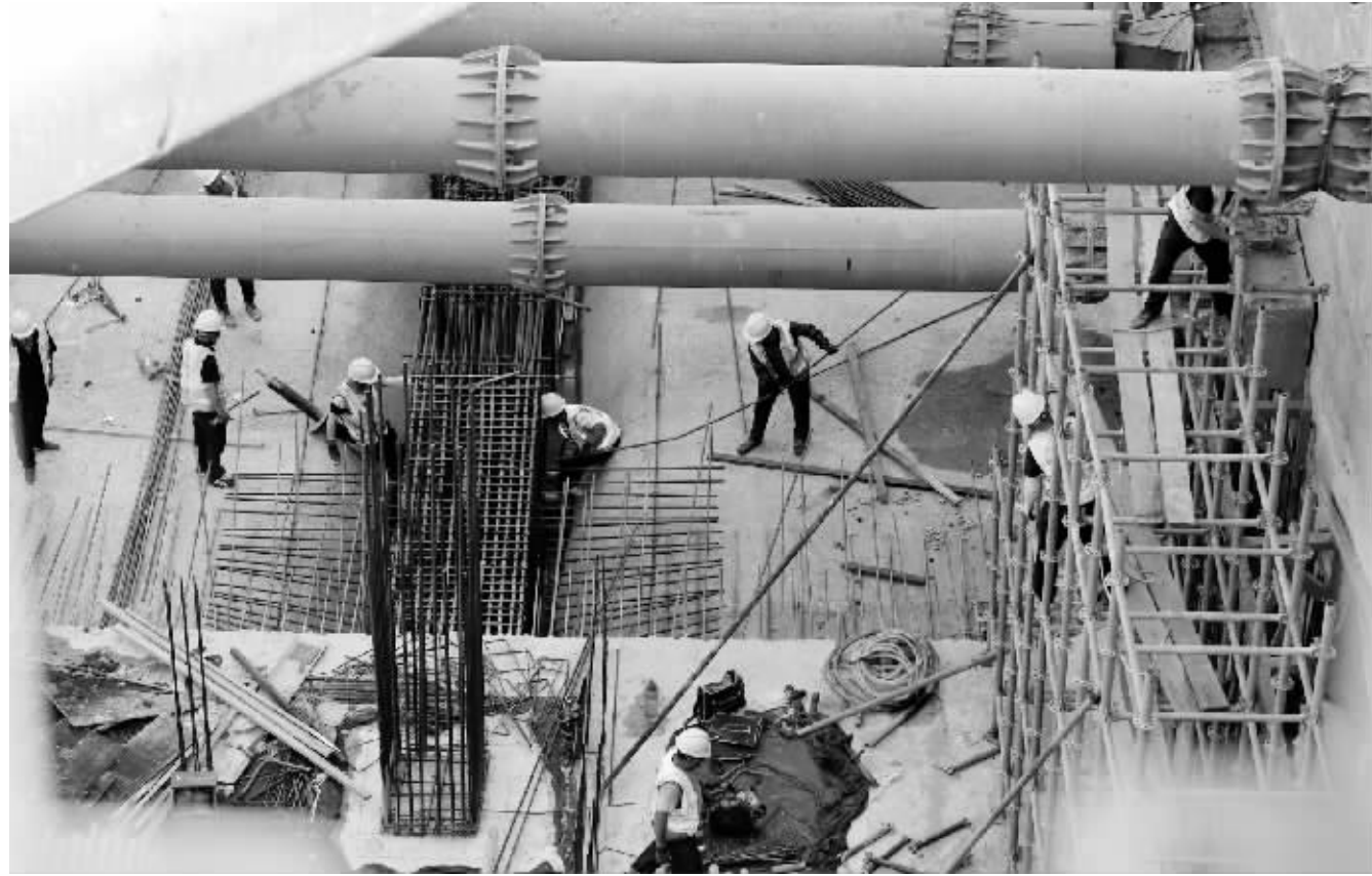
地铁四号线施工建设有序推进
