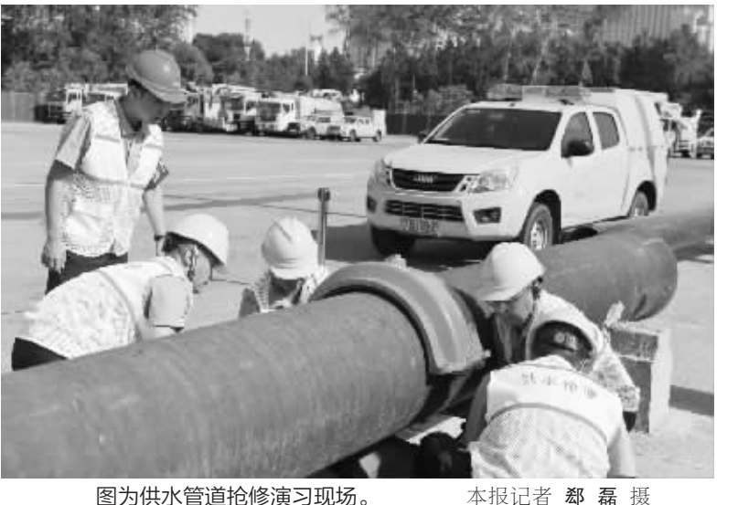
图为供水管道抢修演习现场。 本报记者 郝 磊 摄
