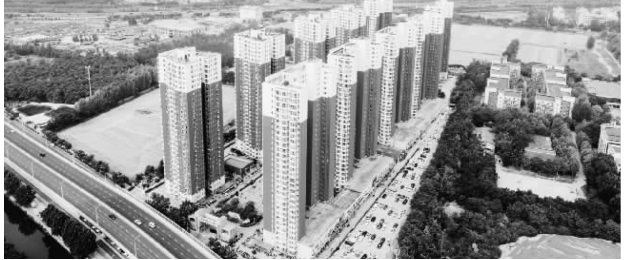
红河小区保障房项目。(摄影:郜湘)
