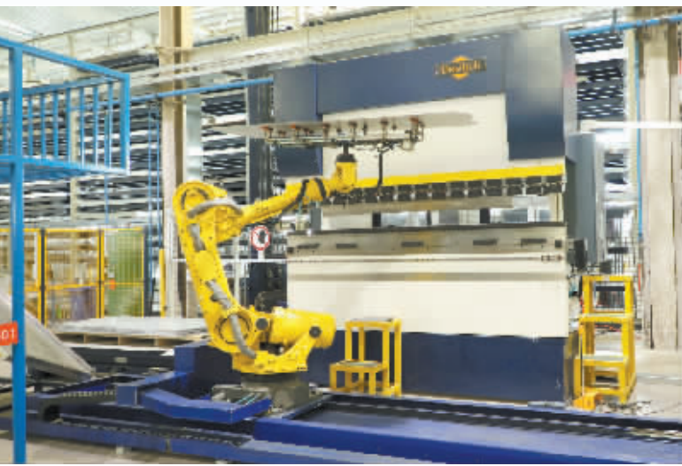
5月29日,在石家庄科林电气股份有限公司智能柔性钣金加工中心,生产线自动调取智能料库中的板材,完成冲切、折弯,无需人工干预。 本报首席记者 张震 摄
