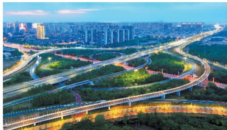
图为五月六日晚,复兴大街裕华路立交桥,将城市装扮得格外亮丽。 本报记者 张晓峰 摄
