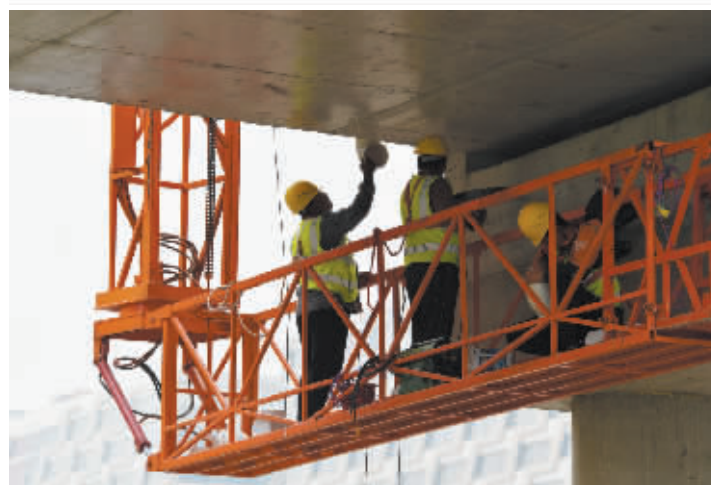
在环城绿道东线施工现场,工人加紧进行路桥配套设备安装。
