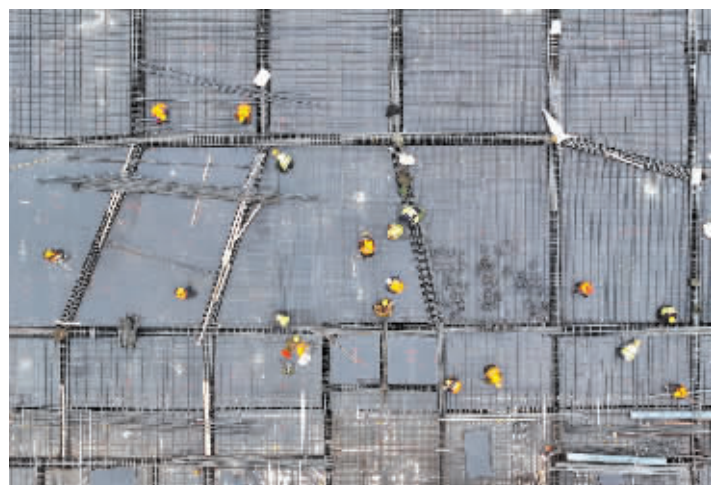
在石家庄市高铁片区,建设者们正在加紧施工。
