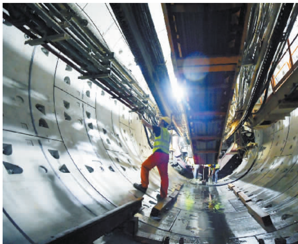
在地铁4号线石友盾构区间,工人检查盾构设备。
