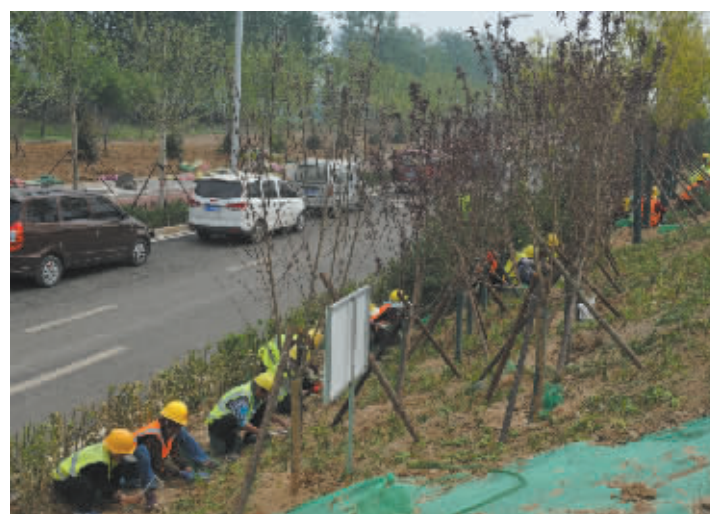
复兴大街两侧,绿化施工正在加紧进行。
