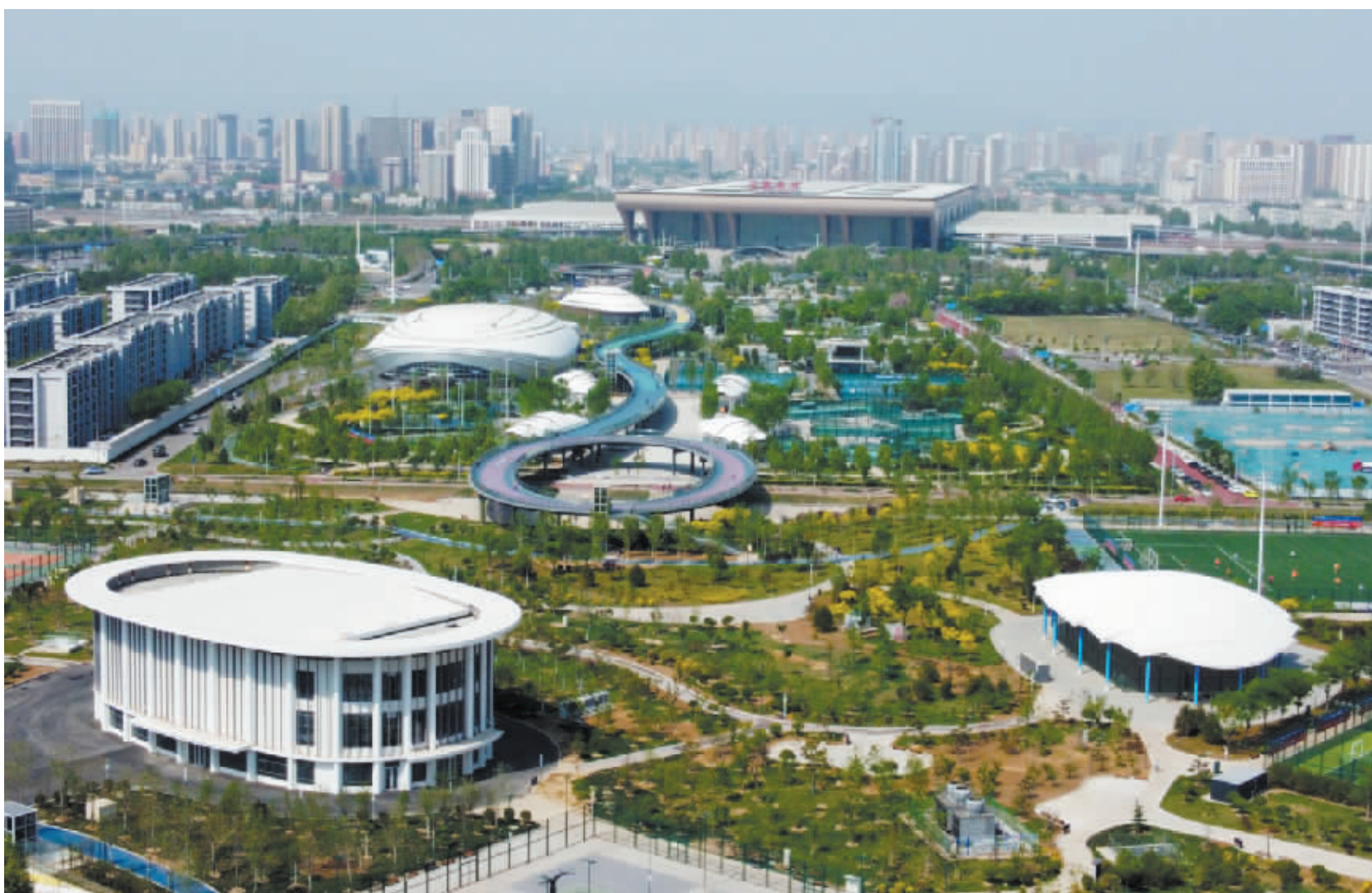
在28.84万平方米的高铁片区中央绿色体育公园,乒乓球竞技馆、健身俱乐部、室内网球场、多功能运动馆等大型独立运动场,宛如一颗颗明珠点缀其上。
