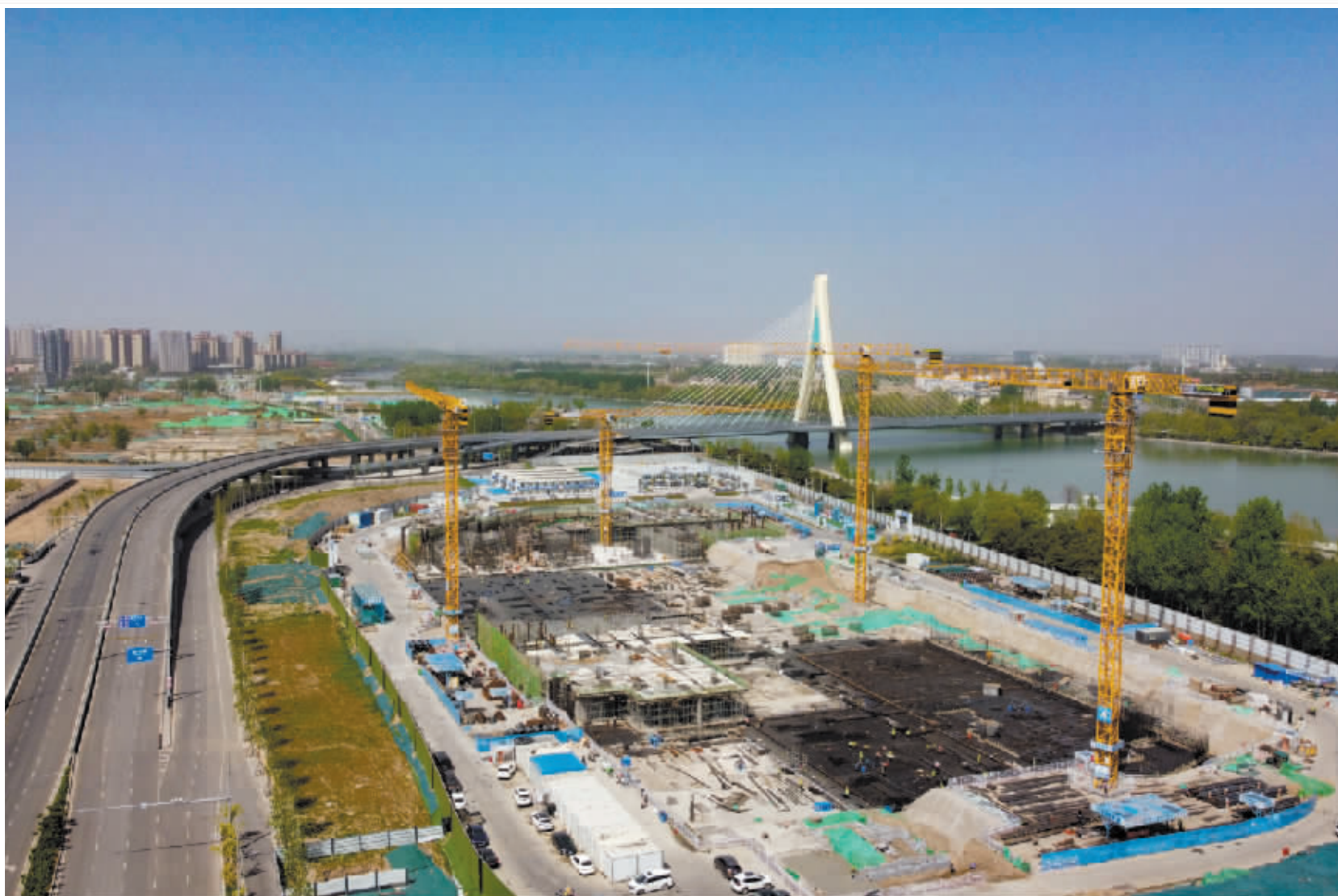
石家庄太平河片区,各项施工加速进行。
