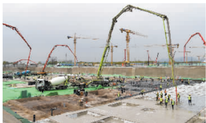
石家庄国际农产品批发交易中心项目二期工程正在加速推进。
