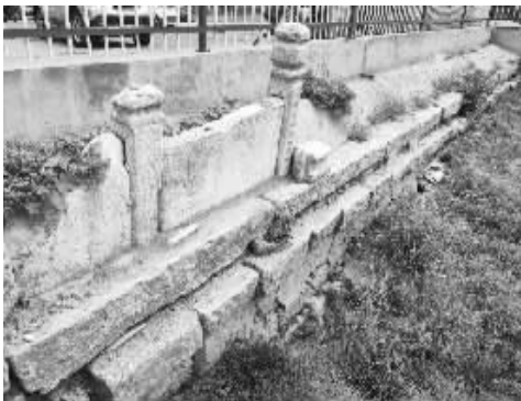
河北省重点文物保护单位升仙桥被誉为安济桥的“姊妹桥”。
