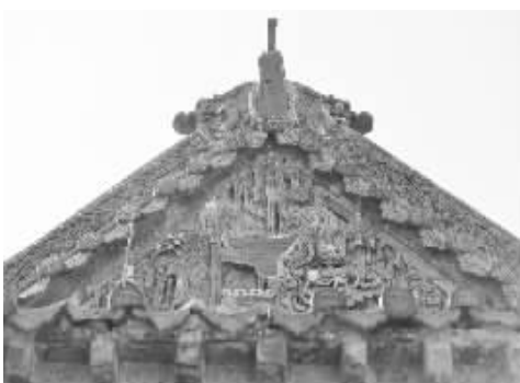
河北省重点文物保护单位琉璃庙为我国仅存的全琉璃构件外饰建筑，琉璃浮雕图案精美生动。
