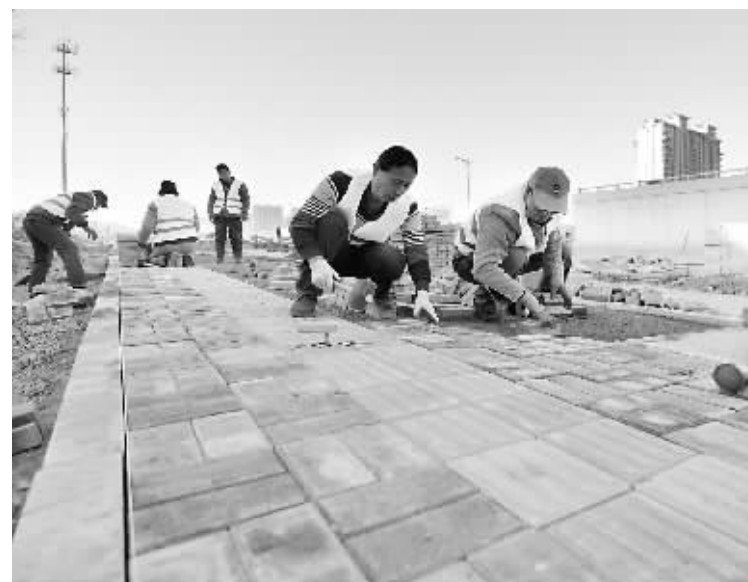
复兴大街市政化改造项目辅路工程目前在加紧建设,各施工单位根据任务节点优化工序衔接,科学合理制定施工计划,确保辅路和剩余工程按期完工通车。图为3月8日,工人在复兴大街辅路(和平路至裕华路)进行便道施工。 本报记者 张晚峰 摄
