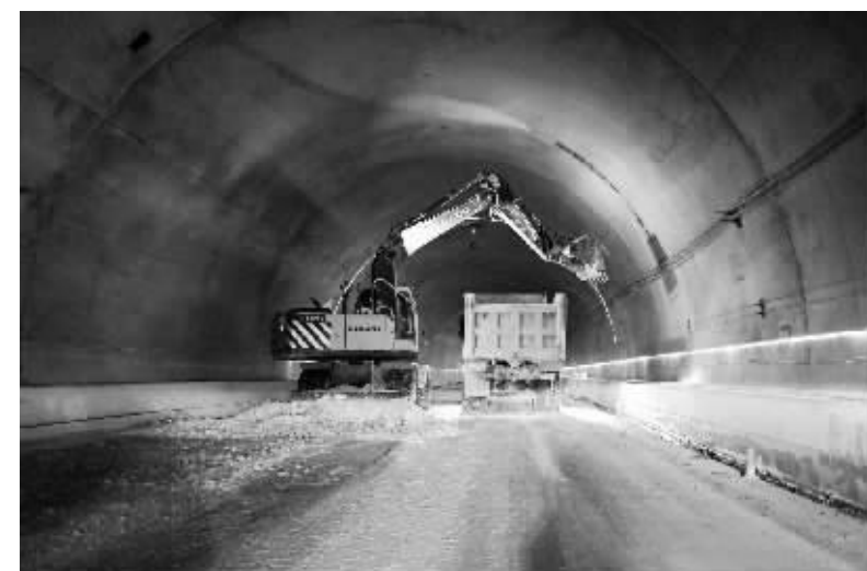
在乌鲁木齐至尉犁高速公路5标段(隧道入口端),工程车辆在主洞清理道路积雪(2月20日摄)。 新华社记者 丁磊 摄
