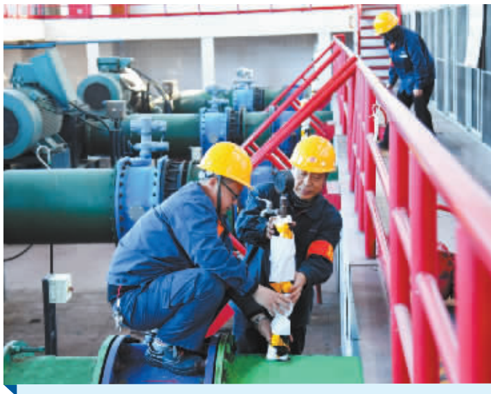
12月20日,石家庄供水有限责任公司八水厂的工作人员对水样管道进行防冻处理。为有效应对低温冰雪天气对供水设施的影响,连日来,该公司工作人员启动了除冰水泵,对供水设施进行了防冻处理,全力保障供水安全稳定。
