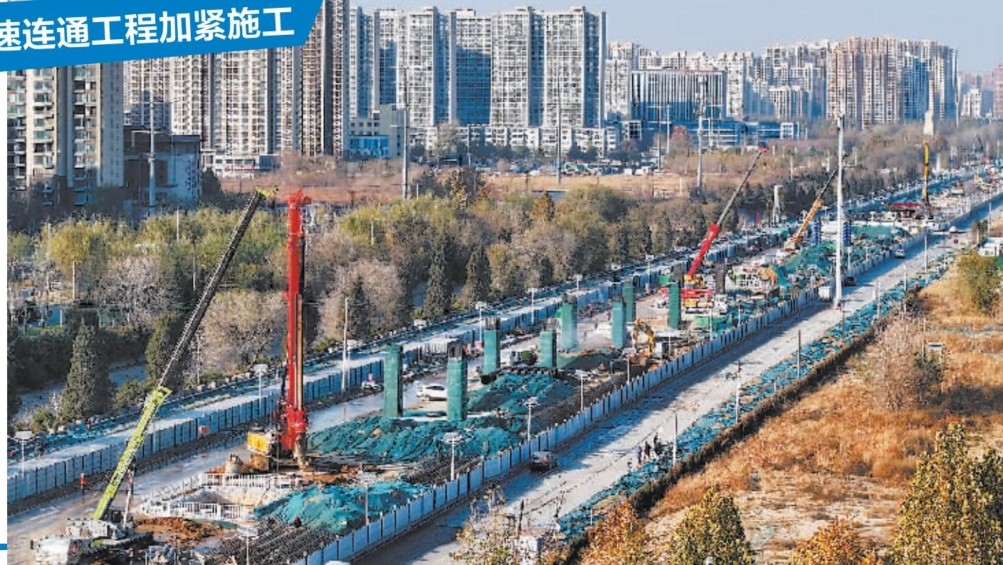
11月28日，在石家庄市裕翔街快速连通工程施工现场，建设者们正在加紧进行高架桥的桥墩施工。该项目建成后，将为拉开省会城市框架，促进石家庄装备制造产业园和东南三环片区的发展提供道路交通保障。
