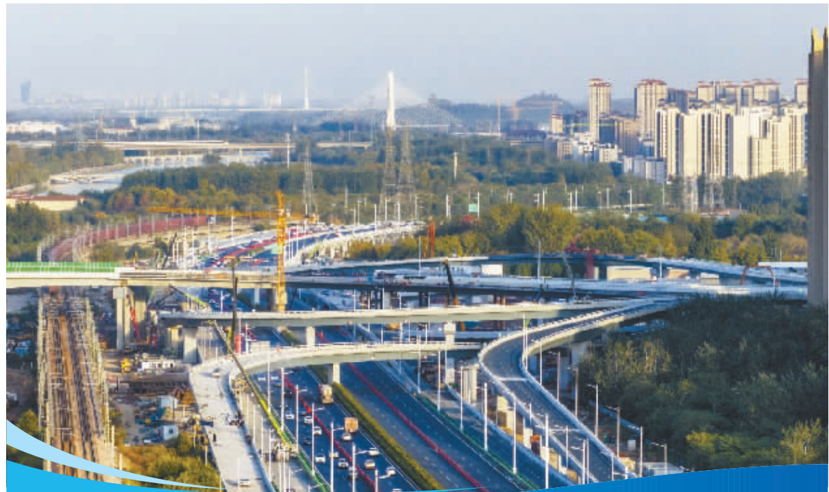
11月5日,石家庄市北三环市政化改造项目中华大街互通立交工程正在加紧施工中。该工程建成通车后,将实现该城北三环与中华大街的互通互联,进一步完善城市路网,有效改善市民交通出行条件。
