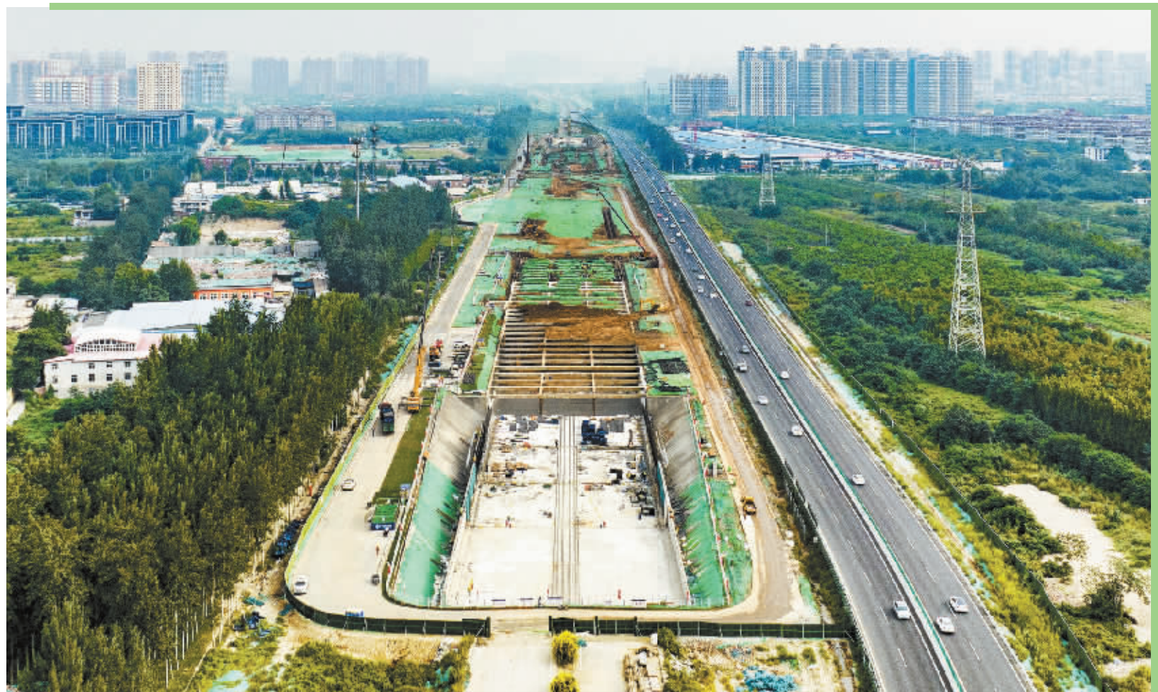
在石家庄市复兴大街市政化改造项目学苑路隧道段的施工现场,建设者合理统筹安排,压紧压实责任全力掀起奋战高潮,做到抓工程进度、保质量安全,确保工程按照预定的时间节点完成。
