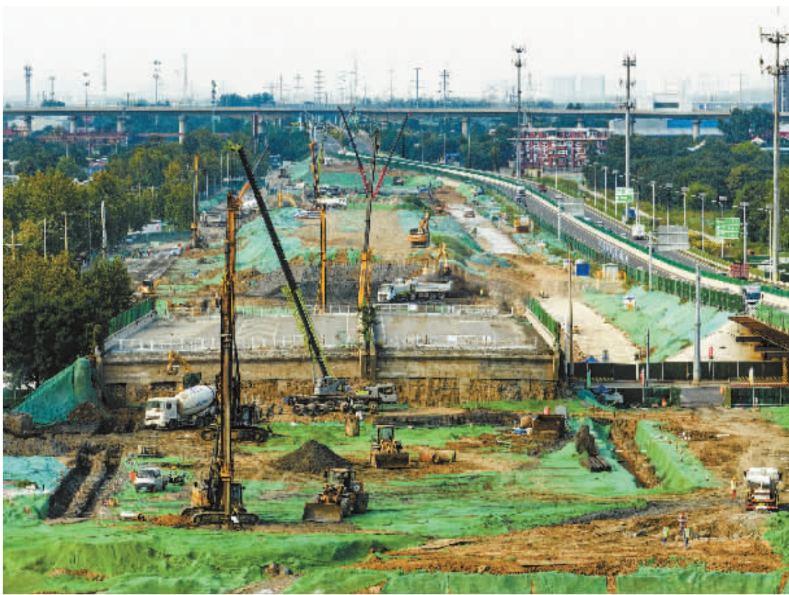
▲9月10日,在石家庄市复兴大街市政化改造项目的工地现场,石家庄交投集团和中国交建等建设单位的施工人员放弃节假日休息时间,以饱满的热情奋战在施工一线。
