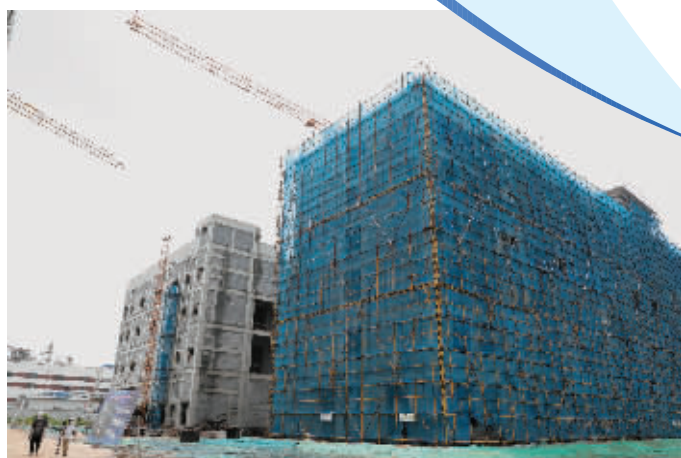
河北安健成益医药科技有限公司在建项目施工现场。
