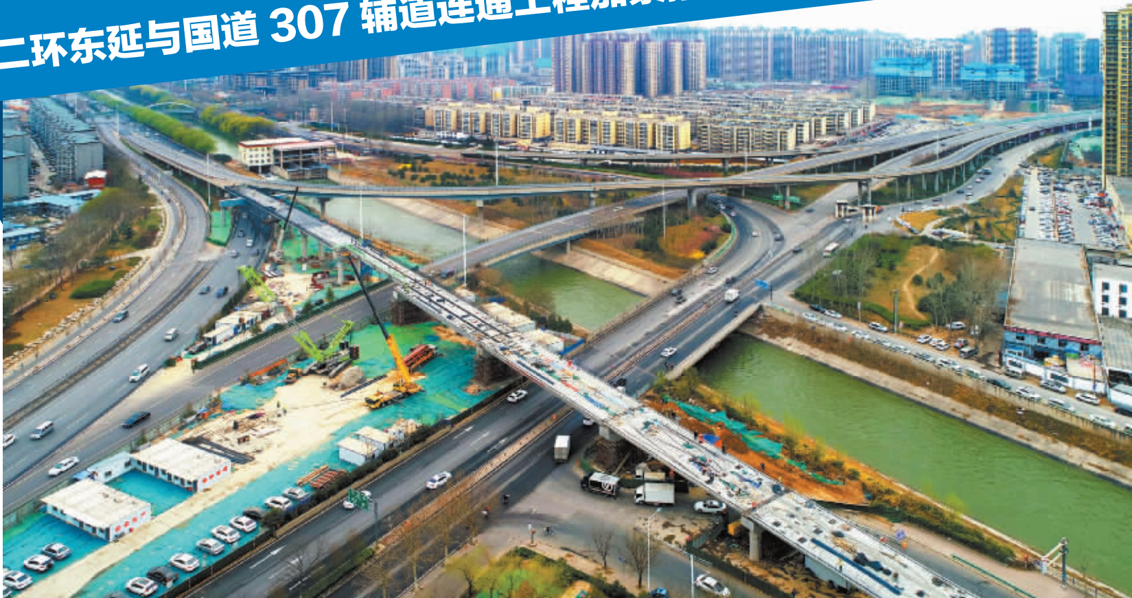
省会北二环东延与国道307辅道连通工程正在加紧推进，333米的跨线桥基本完工。工程建成后，将极大缓解东二环与北二环接口处的交通压力，提高车辆通行能力，对提升城市品位，拓展城市发展空间，加快建设现代化、国际化美丽省会城市发挥重要作用。图为日前拍摄的北二环东延与国道307辅道连通工程跨线桥施工现场。
