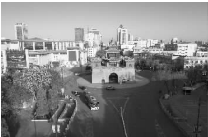
如今,鼓楼不但是银川地标建筑,更成为优秀革命历史传统的重要组成部分。银川市新闻传媒集团记者 范毅强 摄
