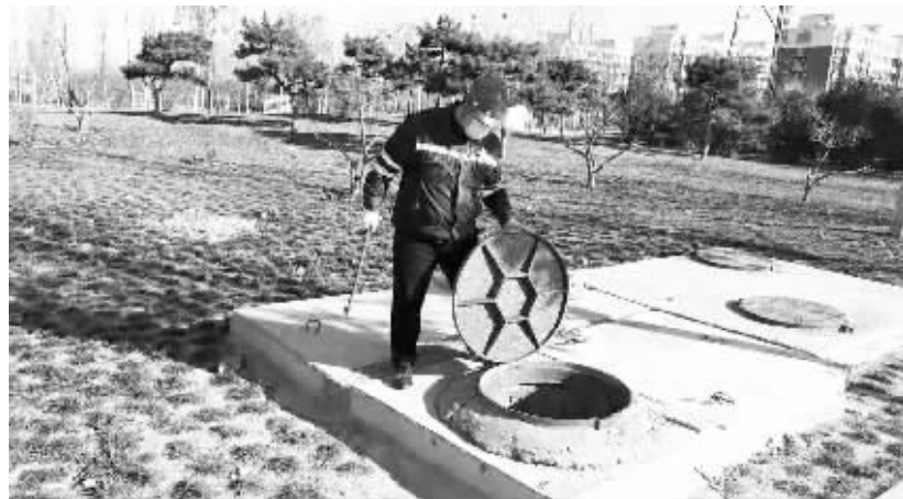
热力公司供热管理三部员工刘杰48小时坚守在岗,加强对辖区管线的巡检。
