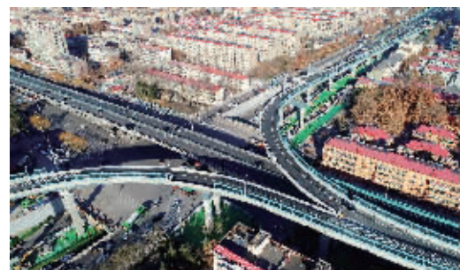
槐安路西二环立交桥工程一期完工，方便了市民出行。
