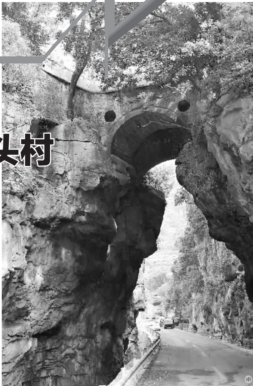
①始建于崇祯十三年（1640年）的凉沟桥依托深涧两侧自然突出的崖石修建。
