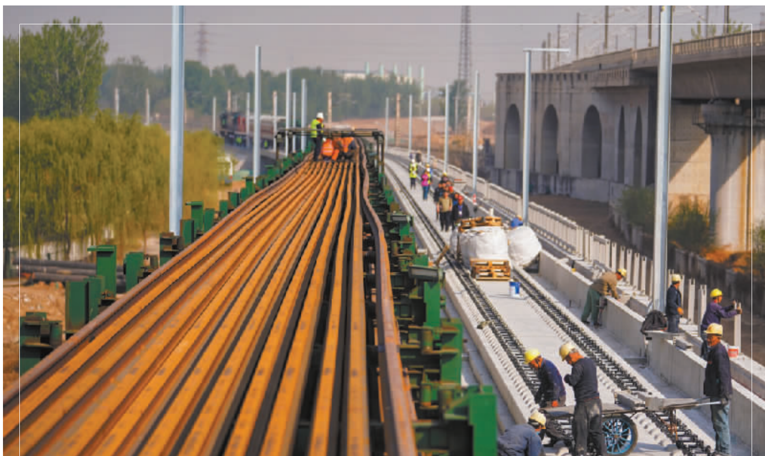
4月15日,中铁十二局集团的建设者在京雄城际铁路李营段施工。当日,北京至雄安城际铁路开始铺轨。京雄城际铁路是连接北京市区、北京新机场和河北雄安新区的重要轨道交通线,正线全长92.4公里,全线设五座车站。按照施工计划,京雄城际铁路预计7月份开始进入试运行调试阶段,9月份与北京大兴国际机场同步开通运营。届时,旅客搭乘高铁列车从北京西站出发到北京大兴国际机场仅需20分钟。(本版图片均为新华社发)
