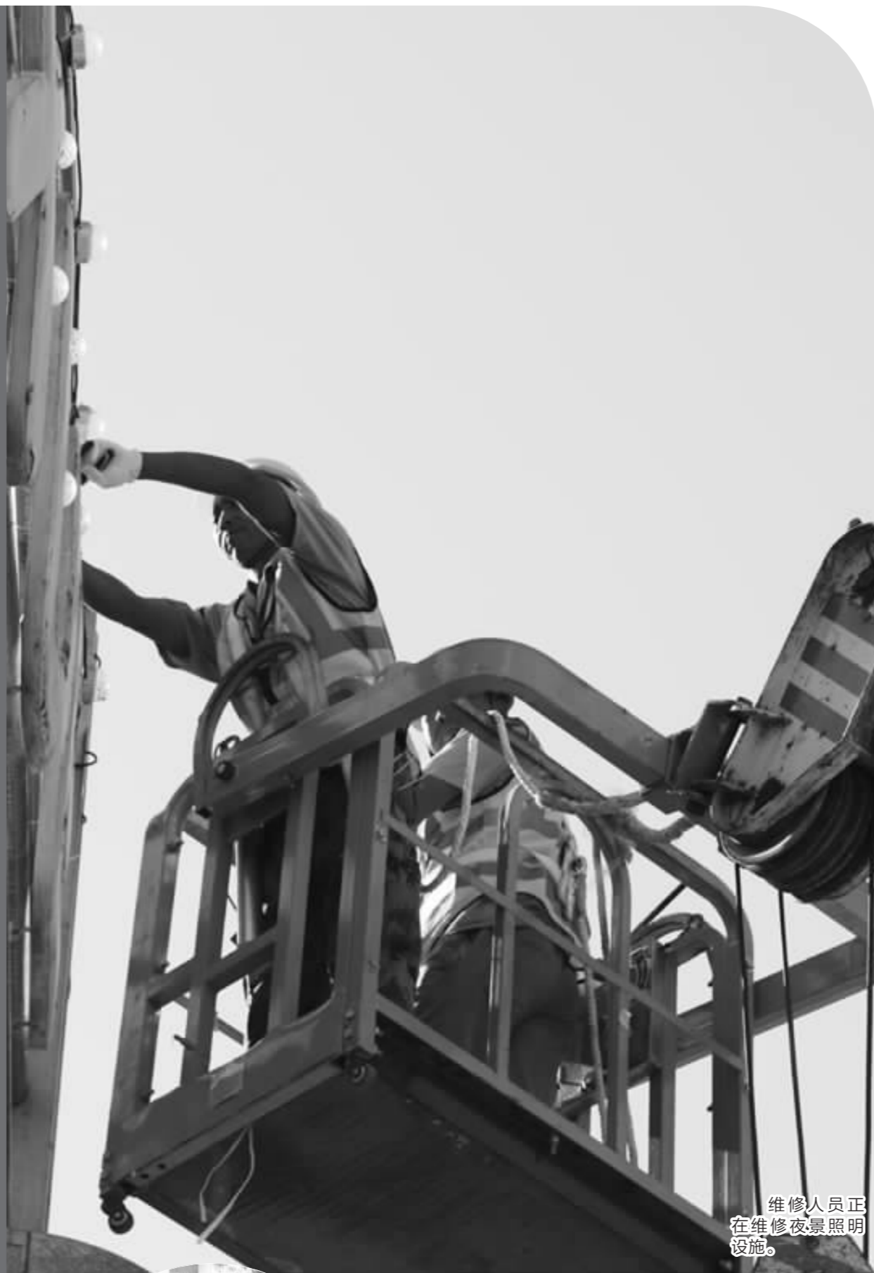
维修人员正在维修夜景照明设施。
