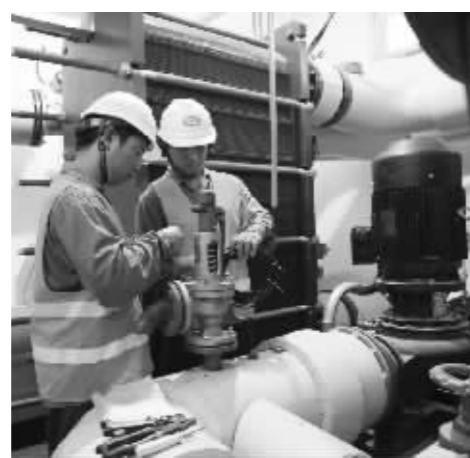
检修供暖设施。
