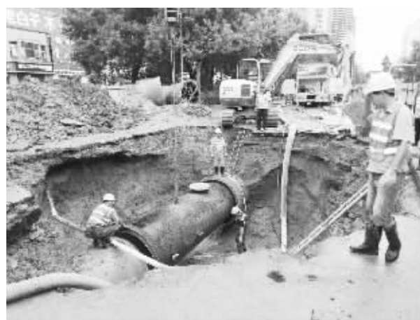
供水管道抢修现场。
