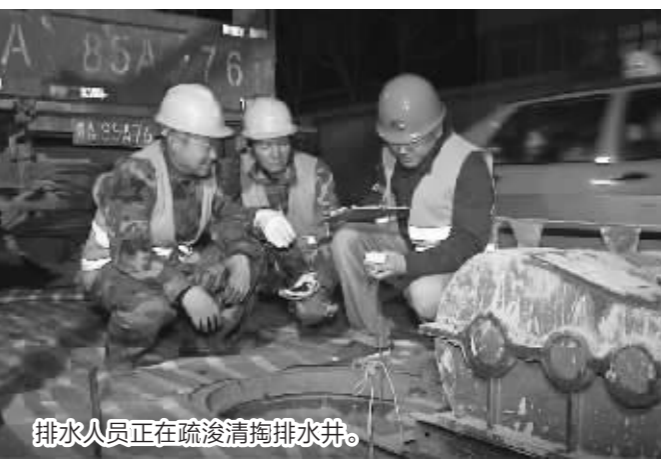
排水工人正在疏通清理排水井。
