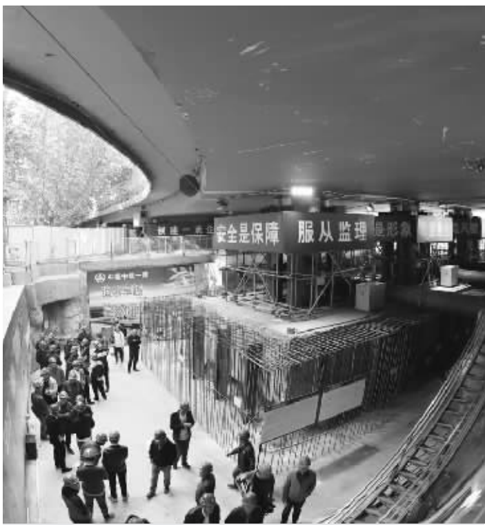
石家庄地铁2号线成功实施建和桥桩基托换。图为施工现场。本报记者 张晚峰 摄
