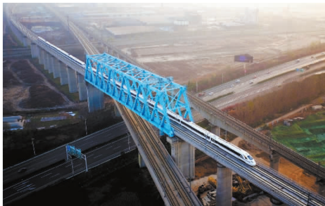
12月6日，西成高铁由西安北站驶出的列车经过西成高铁跨西宝高铁特大桥。
